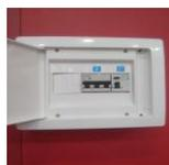
**5-** O CD deverá ser em PVC com fiação seccional, disjuntores e DR compatíveis com as cargas dos estande.
